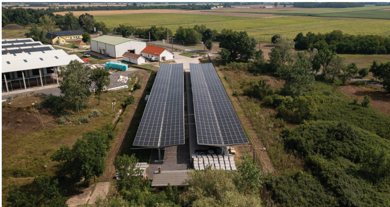
Vésztő (saját erőmű) 500 kWp
