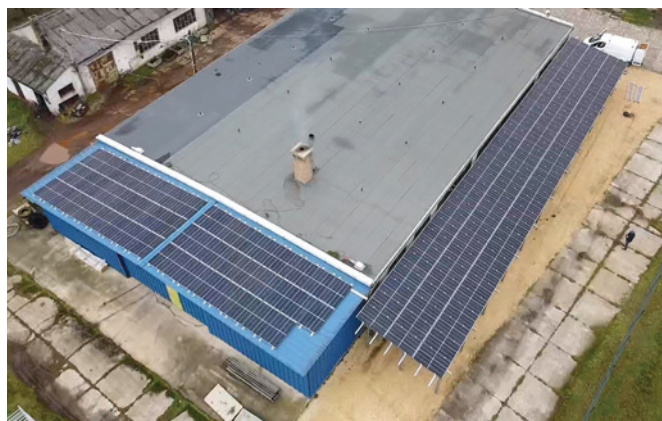
Óhíd (saját erőmű) 50kWp
