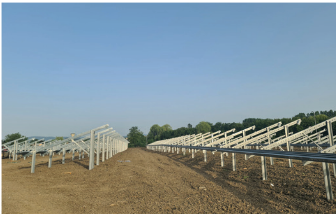
Aiud (Nagyenyed) 1 MWp
